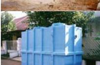
Teknologi pengolah air limbah rumah tangga semi komunal "kombinasi biofilter anaerob dan aerob"
